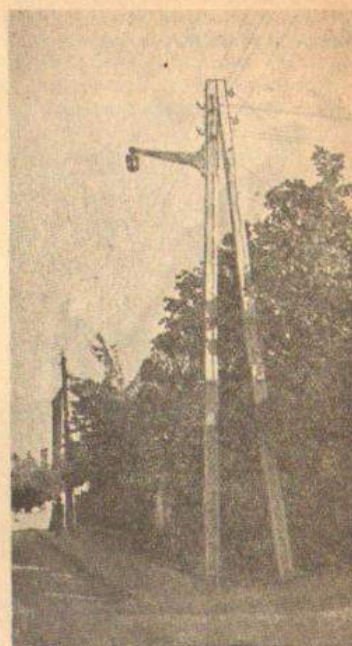
Rys. 27. Słup A-owy typu „Ala” pracujący jako odporowo-narożny (Warszawa-Bielany)
