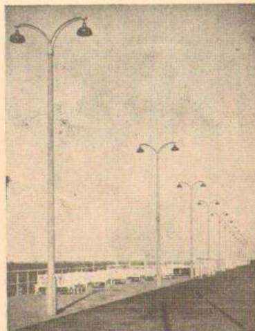
Rys. 42. Słupy typu „WZ” dwuramienne; wysokość punktu świetlnego 7,50 m nad poziomem (Molo Prezydenta w Gdyni)
