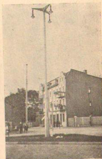
Rys. 40. Słup typu „Lot” z głowicą trójramienną; wysokość punktu świetlnego 8,5 m nad poziomem
