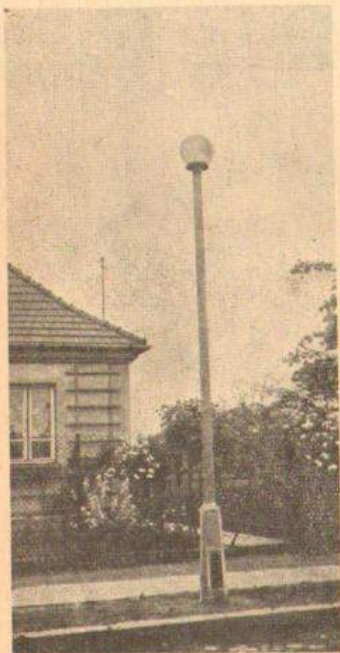
Rys. 35. Słup typu „Kula EK”; wysokość punktu świetlnego 4,30 m nad poziomem
