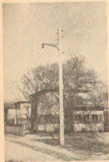
Rys. 24. Słup typu popularnego „Ala”; wysokość punktu świetlnego 7 m nad poziomem (Warszawa-Bielany)
