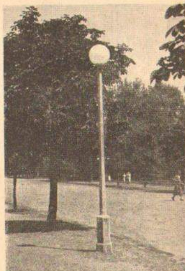
Rys. 31. Słup latarniowy typu „Kula EW” szlifowany; wysokość punktu świetlnego 3,65 m nad poziomem (Park Paderewskiego — Warszawa)
