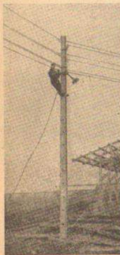
Rys. 106. Monter przy pracy na słupie typu „Ala”
