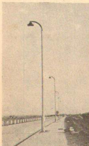
Rys. 41. Słupy typu „WZ” jedno-ramienne; wysokość punktu świetlnego 9 m nad poziomem (Wał Miedzyszyński w Warszawie)
