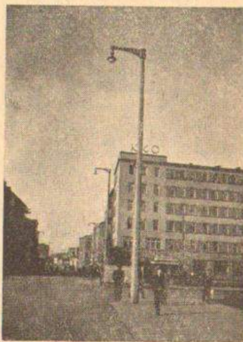
Rys. 58. Słup oświetleniowy o równomiernej zbieżności bez cokołu, wysokość 9 m (Gdynia)
