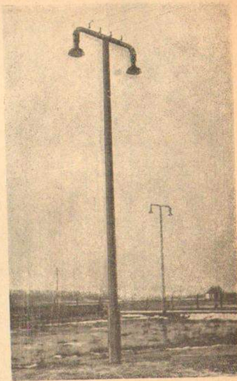
Rys. 52. Słupy do oświetlenia gazowego; punkt świetlny 10,50 m nad poziomem, na wysięgniku przewodów telekomunikacyjne (Miejska Oczyszczalnia Ścieków — Kielce)
