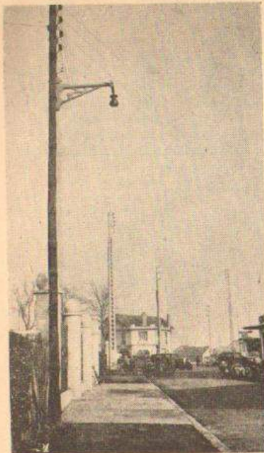
Rys. 30. Wysięgnik żelbetowy do lamp ulicznych na słupie drewnianym. Uwaga. Niezbyt estetyczny przykład naśladowania w betonie form właściwych konstrukcjom żelaznym. Zdjęcie pochodzi z jednego z miast francuskich
