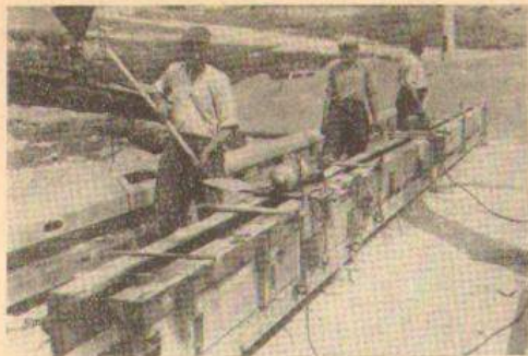
Rys. 76. Wibratory przyczepne pracujące na wierzchu formy
