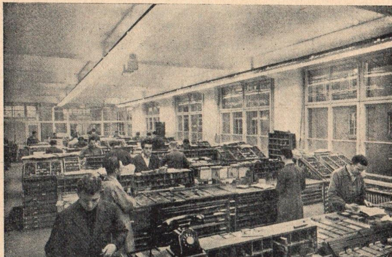
Rys. 33. Oświetlenie ogólne zecerni. Oprawy do oświetlenia prze- ważnie bezpośredniego, połączone w pasy biegnące przez całe po- mieszczenie, zapewniają dobre oświetlenie miejsc pracy i stwarzają pogodny nastrój
