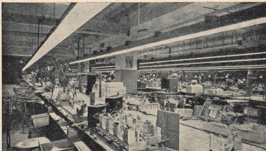
Rys. 39. Oprawy zawieszone na odpowiedniej wysokości, połączone w pasy ciągle biegnące nad stanowiskami roboczymi, stanowią oświetlenie ogólne, zwane zlokalizowanym
