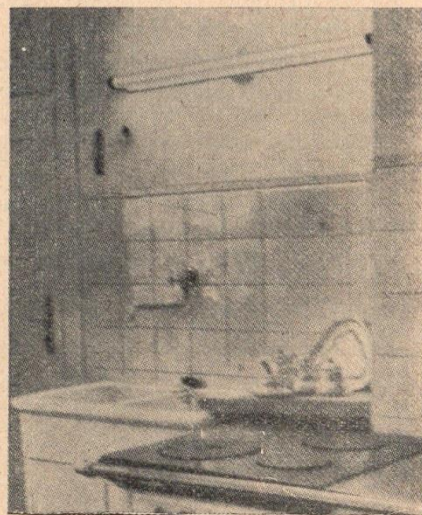
Rys. 58. Jasne ściany i urządzenie kuchni pozwalają na stosowanie światłówki nieosłoniętej, gdyż w tych warunkach jej jasność nie powoduje olśnienia
